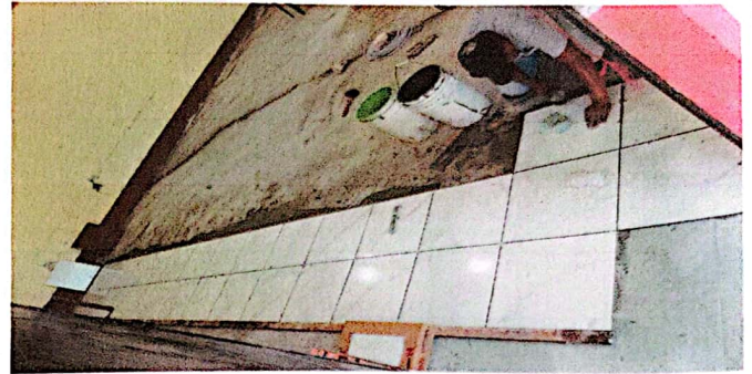
FOTO 2: Sustrucción de piso cerámico
