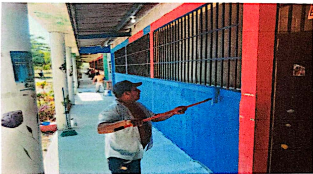
FOTO 3: Pintura en muros exteriores e interiores
