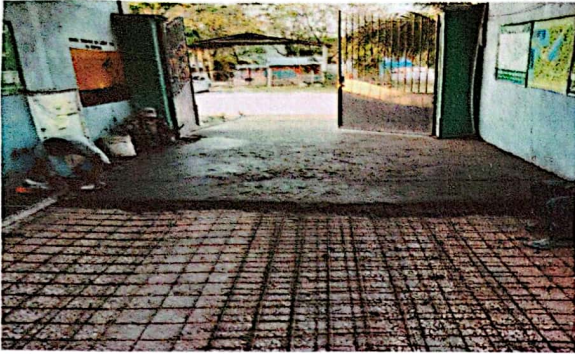
FOTO 1: Sustrucción de piso de torta de concreto
